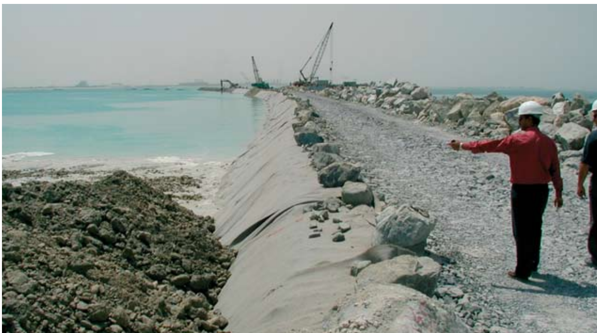
Kilde: Palm Island, Dubai. Installation af Fibertex F-650M. Fibertex Geotextilet vil blive dækket helt af grus og sand.
